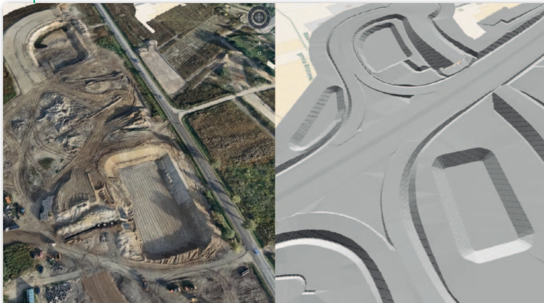
Porównanie bieżącej sytuacji terenowej z modelem projektowanych robót ziemnych na S7 (węzeł Mława Wschód)
