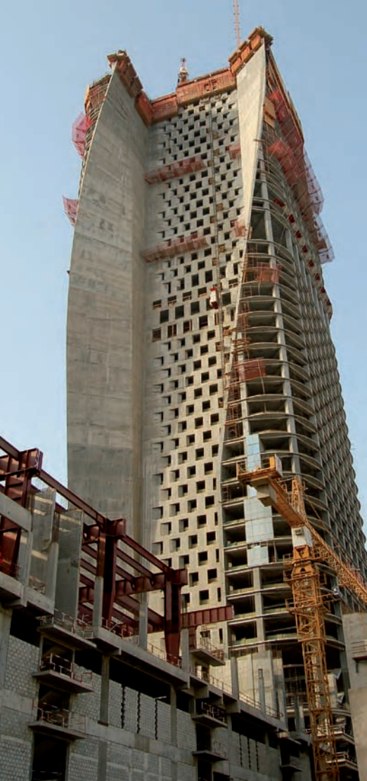
Fot. Kuwejt - budowa wysokościowca Al-Hamra (docelowa wysokość 416 m)
