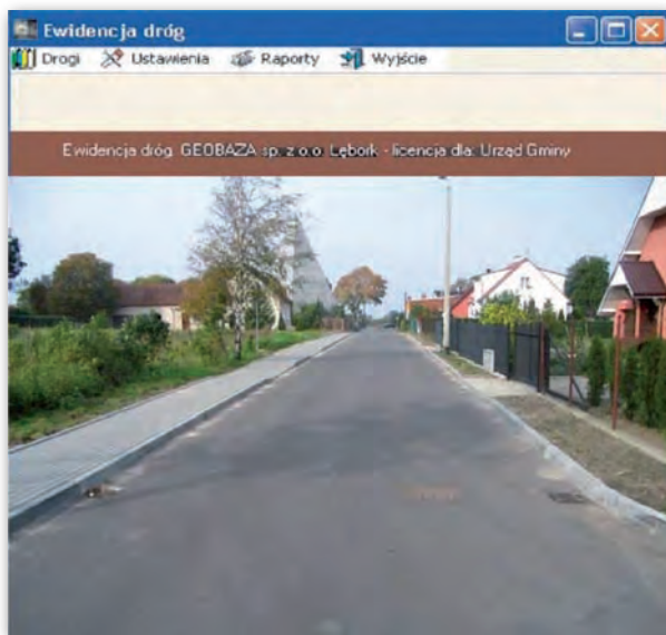
Moduł EDS – ewidencja dróg samorządowych, narzędzie do zakładania oraz prowadzenia części opisowej ewidencji dróg
