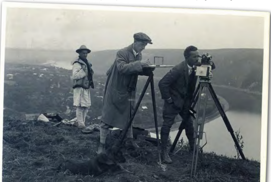
Granica polsko-rumuńska. Pomiary z użyciem fototeodolitu i stolika topograficznego
