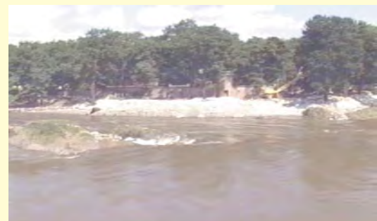
▲ Jaz Szczytnicki – widok na ZOO. W yraźnie widoczny fragment terenu oderwany przez wodę, zdjęcie wykonane kamerą wideo
