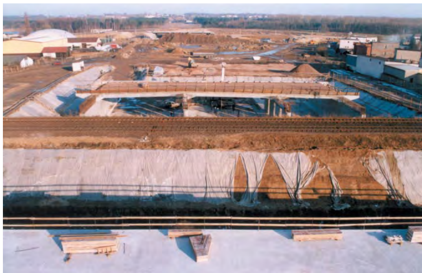
Fot. 1. Sytuacja przed przesuwem. Na pierwszym planie istniejące torowisko, w głębi segment tunelu do przesunięcia
