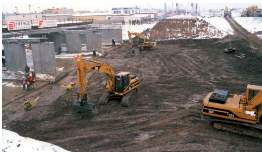
Fot. 2. Końcowa faza rozbiórki nasypu
