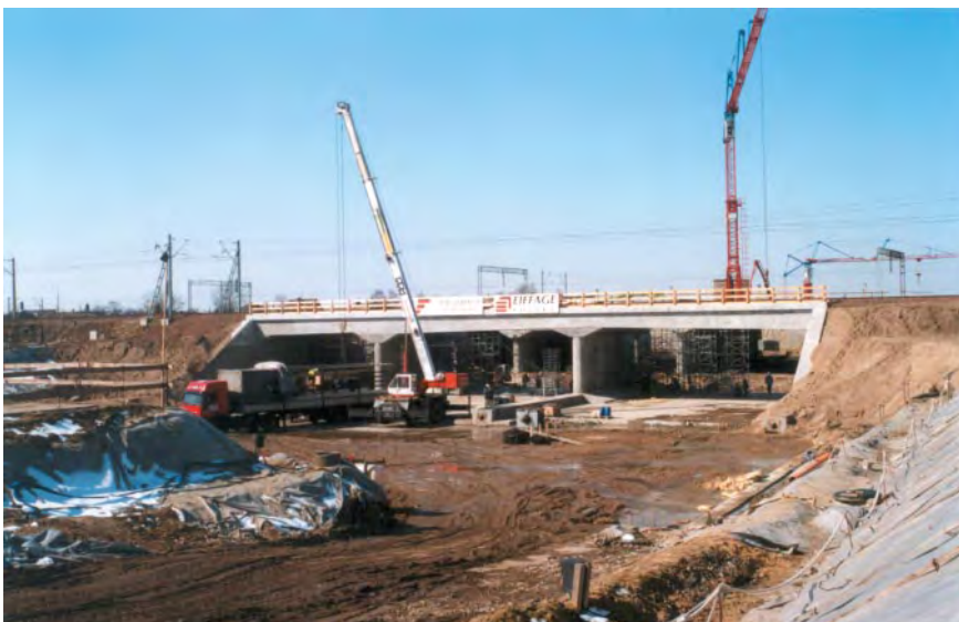
Fot. 4. Dzień po operacji. Tunel na swoim miejscu
