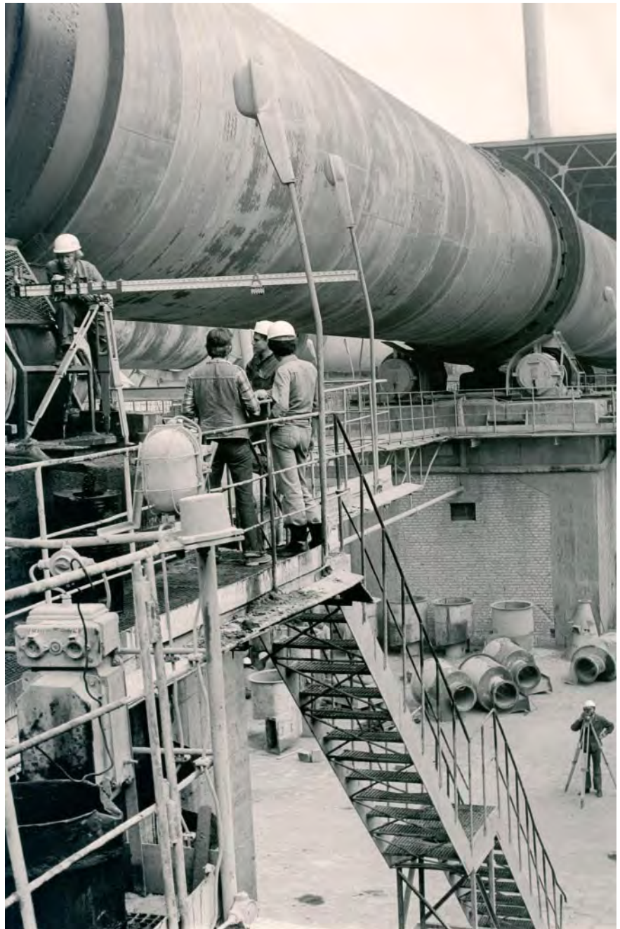
Powyżej: Osiowanie pieca obrotowego
