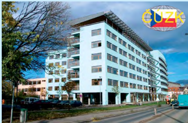
Siedziba Czeskiego Urzędu Geodezji i Katastru
