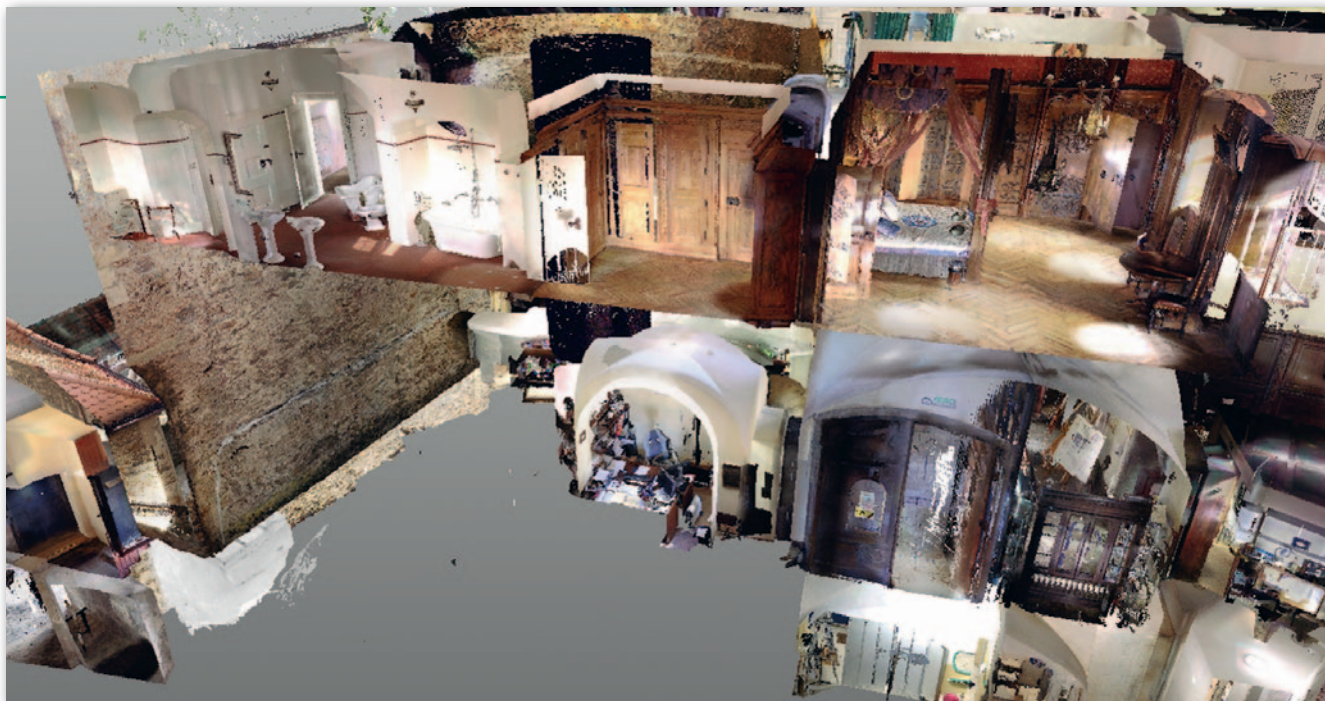
Rys. 3. Potencjalne puste przestrzenie pod łazienką królewską
