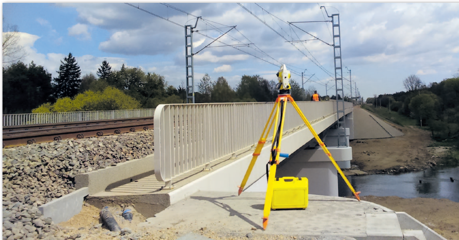
Modernizacja linii kolejowej LK6
