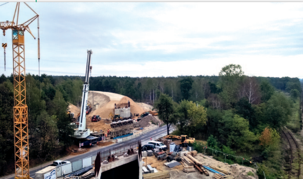
Modernizacja linii kolejowej LK6
