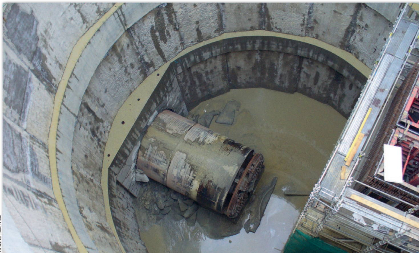
Finiał drążenia tunelu w komorze po lewej stronie Wisły
