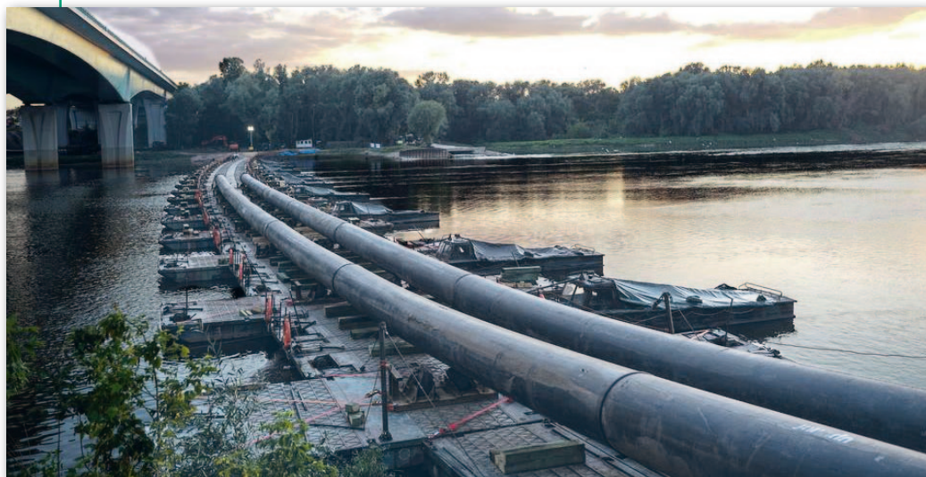
Budowa tymczasowego rurociągu po moście pontonowym we wrześniu 2020 r.
