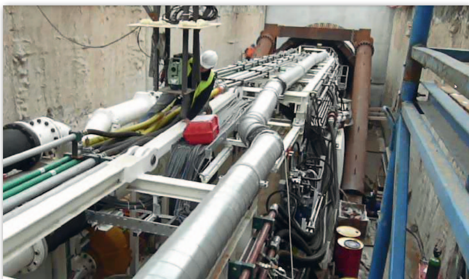
Początek drążenia tunelu przez maszynę TBM, na zdjęciu pierwsze stanowisko pomiarowe
