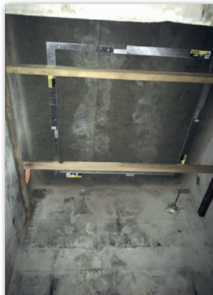
Fot. 2. Rama pomiarowa powieszona w nadszymbiu
