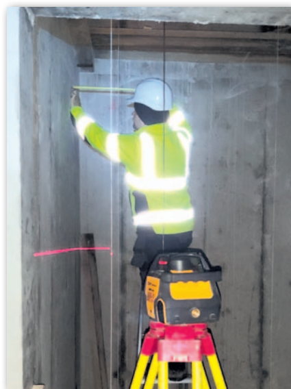
Fot. 8. Pomiar odległości ściany od pionu
