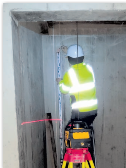
Fot. 7. Oznaczenie poziomu pomiarowego
