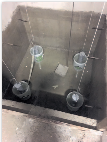
Fot. 5. Obciążone piony w podszybiu
