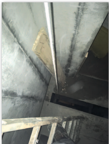
Fot. 4. Opuszczanie pionu przez zdemontowane deski zabudowy tymczasowego podestu w szybie
