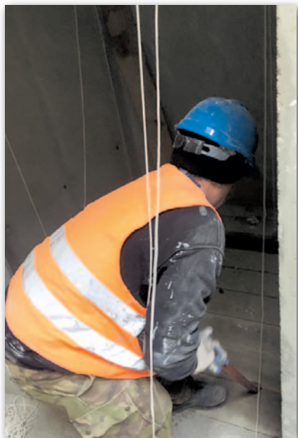
Fot. 3. Pracownik budowy demontuje zabudowę szybu windowego
