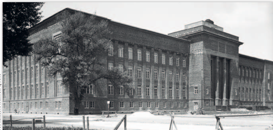
Budynek główny Akademii Górniczej w trakcie budowy, stan z roku 1927
