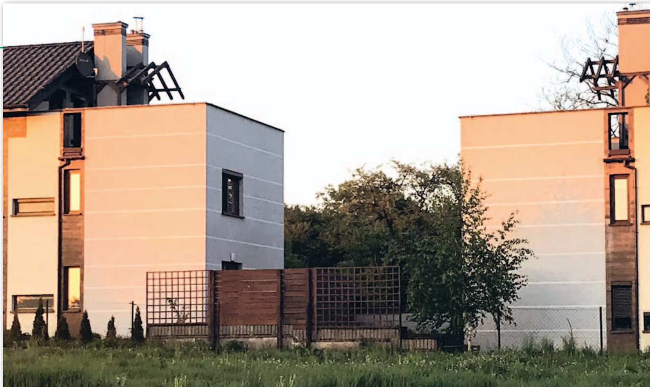
Rys. 1. Budynek podziemny zagłębiony poniżej poziomu przylegającego terenu co najmniej w połowie wyłącznie od strony zachodniej. Od strony wschodniej znajduje się wjazd do budynku (miejsca garażowe) z poziomu terenu do niego przylegającego
