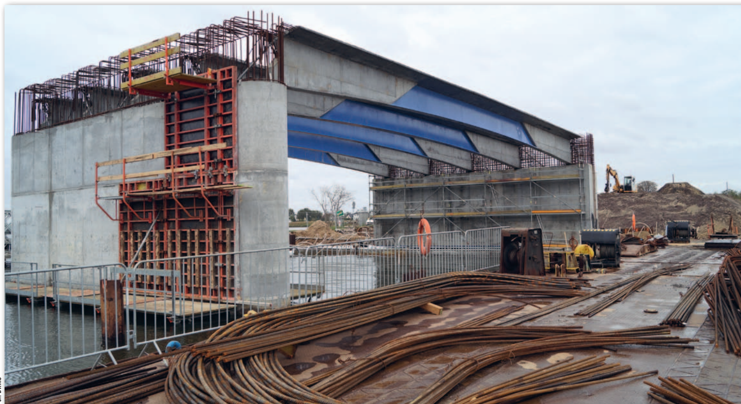
Budowa mostu sobieszowskiego – połowa października 2017 r.
