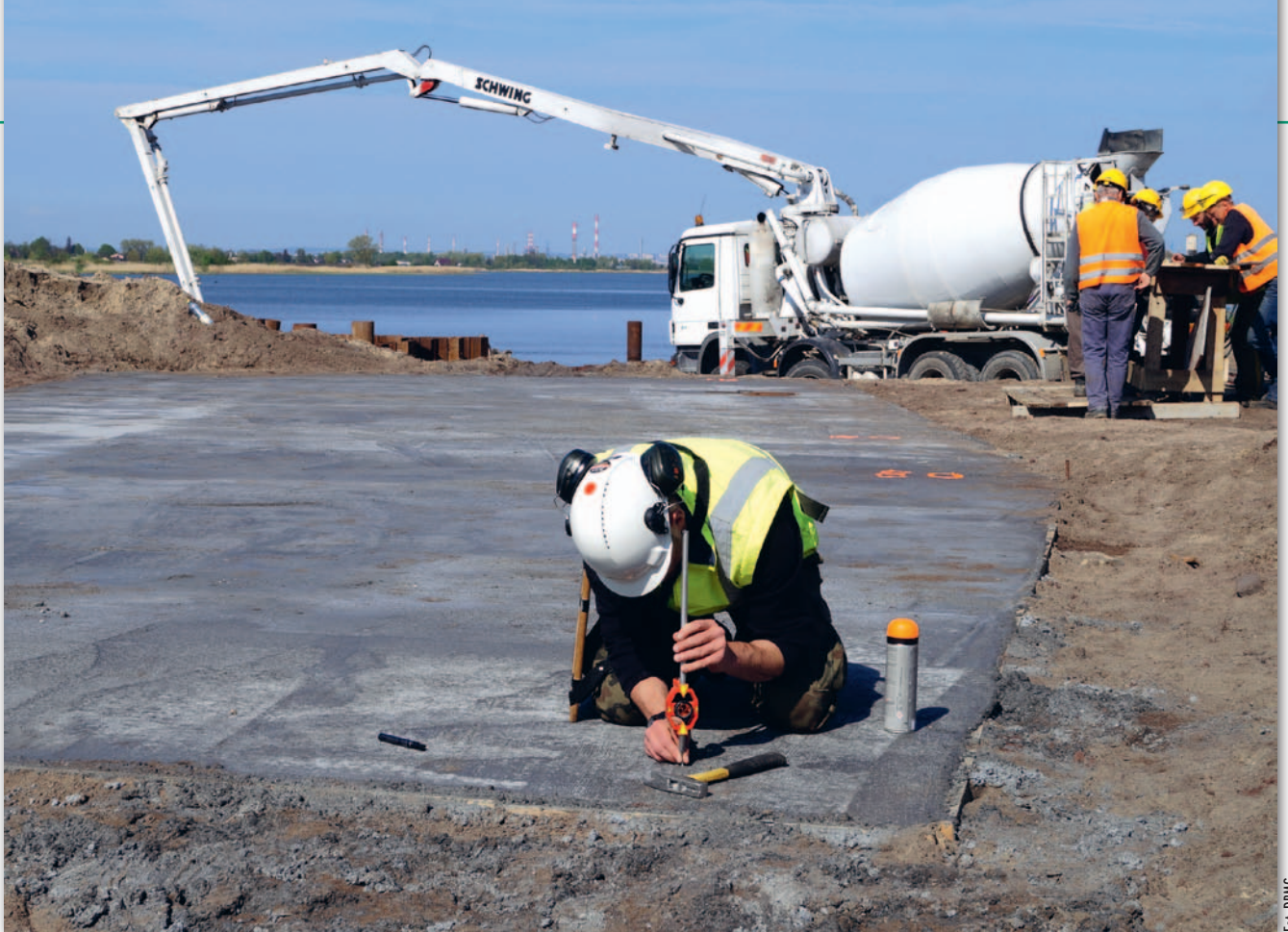
Tyczenie na stopie fundamentowej
