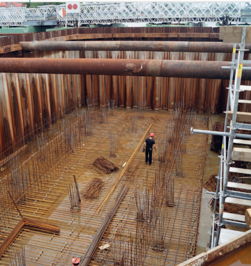
Tyczenie na stopie fundamentowej
