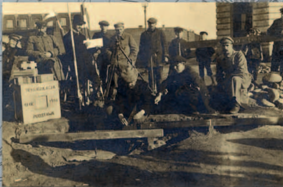
Ostatnie czynności przy pomiarze bazy na punkcie „Bn” w dniu 7.11.1918 r.. Obserwacje prowadzi inż. Bobrowski, z dziennikiem w rękę – technik Jastrzębski. Widoczna betonowa pokrywa znaku z napisem: TRYANGULACJA – 17 IX 1918 – PODSTAWA
