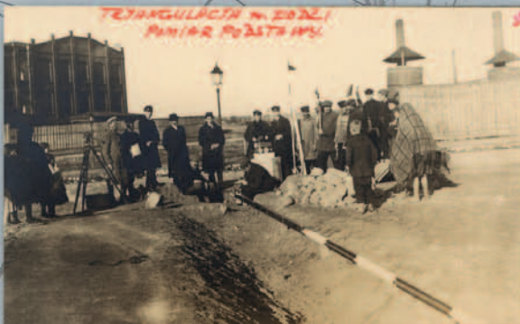
Ostatnie czynności przy pomiarze długości podstawy łódzkiej sieci triangulacyjnej na skrzyżowaniu z ul. Średnią (Pomorską).
