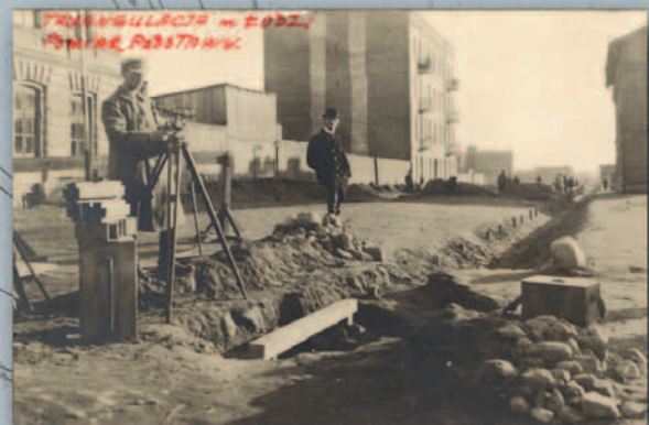
Pomiar długości bazy, obok teodolitu ustawionego prostopadłe do osi bazy przy punkcie „Bn” stoi inż. Wacław Bobrowski, dalej technik Włodzimierz Jastrzębski
