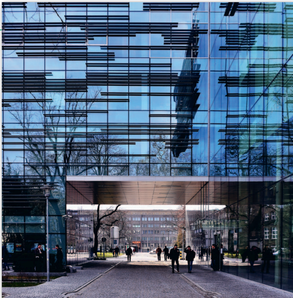
Gmach Matematyki PW. Fragment elewacji z poziomymi listwami – łamaczami światła
