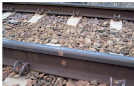
c) punkt bazowy nacięty na zewnętrznej, bocznej płaszczyźnie główki szyny wykonywany podczas pierwszego pomiaru i dodatkowo oznaczony białą farbą
