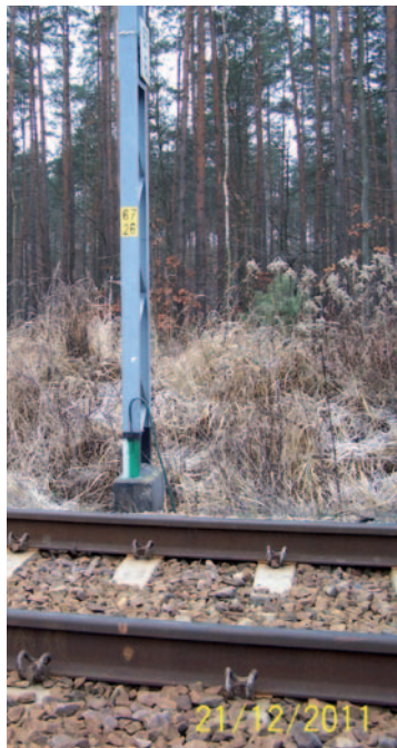
a) punkt stały – punkt odniesienia założony na stalowym słupie trakcyjnym oznaczony kolorami zgodnie z wymogami instrukcji Id-1 (D-1)
