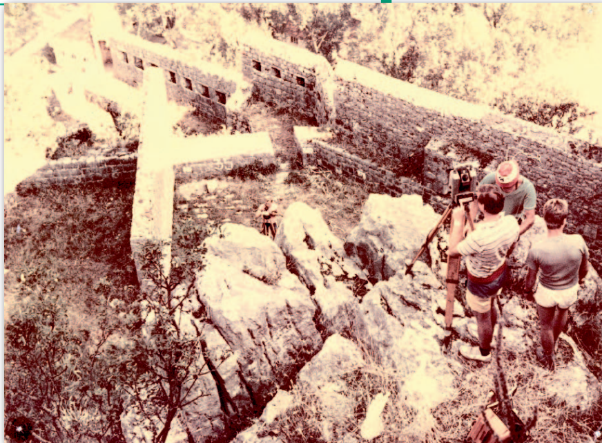
Prace terenowe przy inwentaryzacji fotogrametrycznej murów Kotoru
