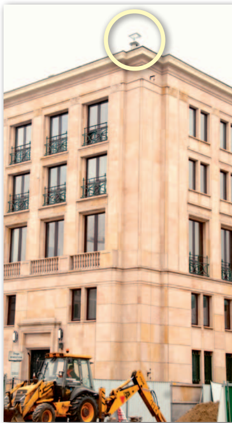
Tachimetr zamontowany na dachu Ministerstwa Finansów przy budowanej stacji „Nowy Świat”
