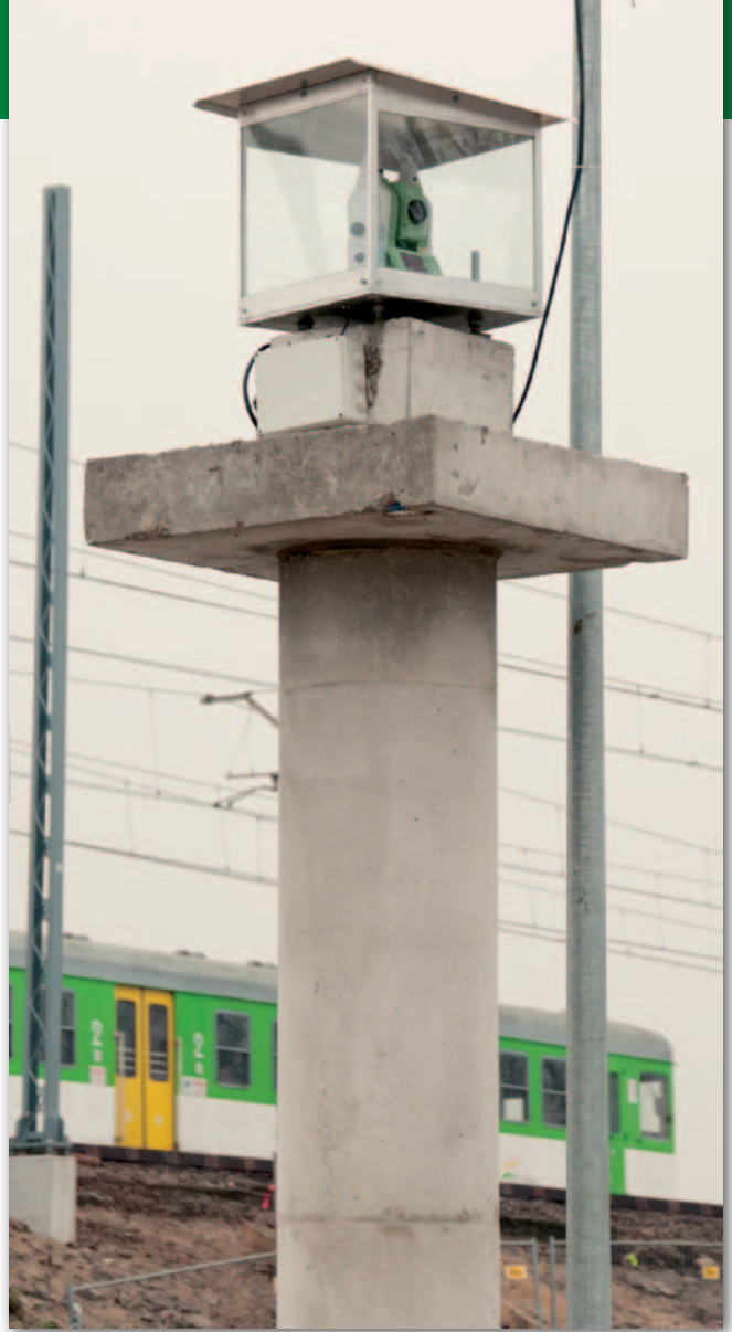
Tachimetr Leica TM 30 monitorujący okolice stacji Warszawa Stadion
