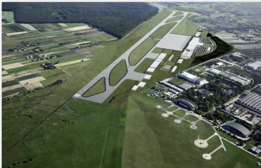
Faza II realizacji projektu międzynarodowego portu lotniczego w Lublinie; obecnie trwa faza I
