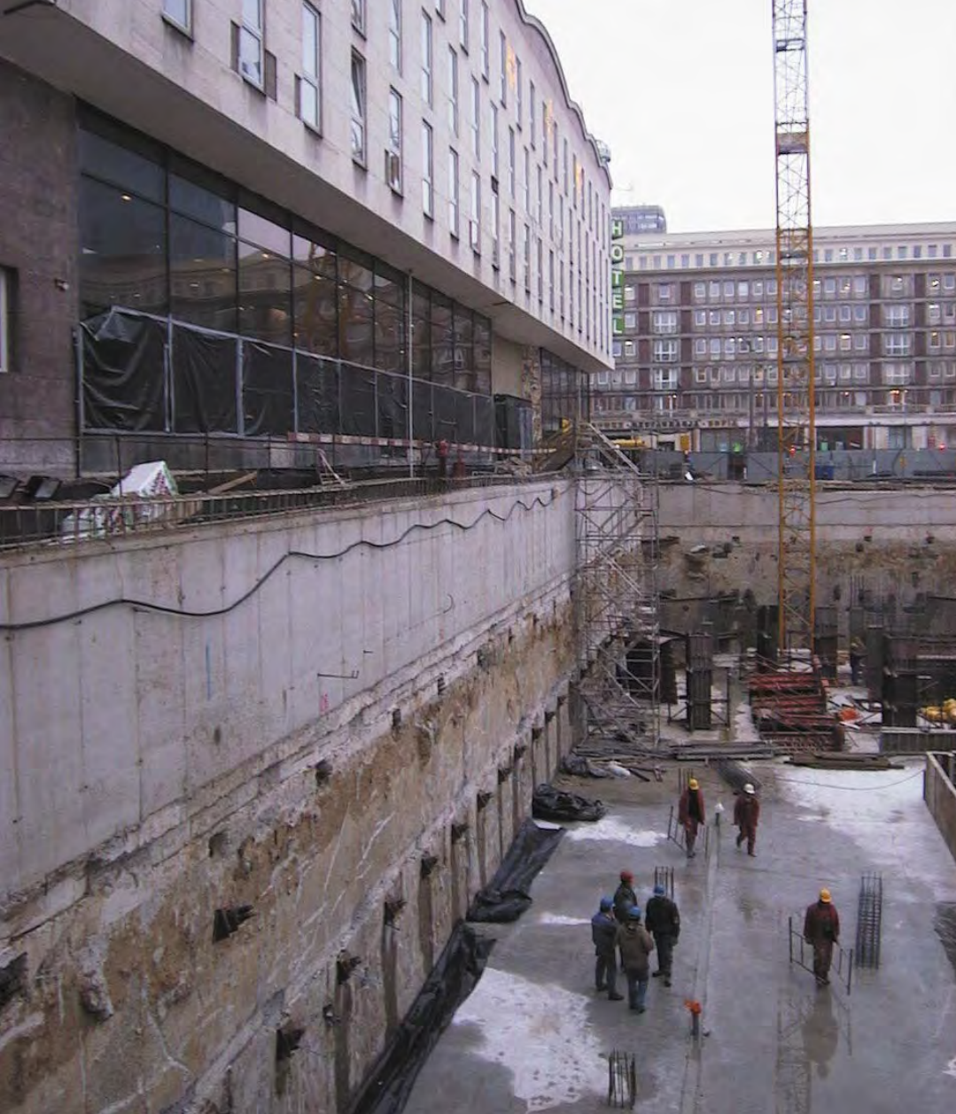
Głęboki wykop pod garaż podziemny w sąsiedztwie hotelu Dom Chłopa w Warszawie, jak się okazało, nie zagrażał stabilności jego fundamentów
