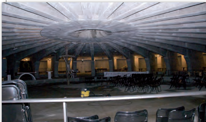
Sklepienie dolnego kościoła; w środku 2-metrowy świetlik
