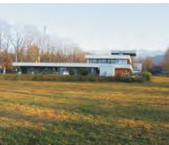
Fot. 2. Stacja Hydrologiczno-Meteorologiczna w Zakopanem
