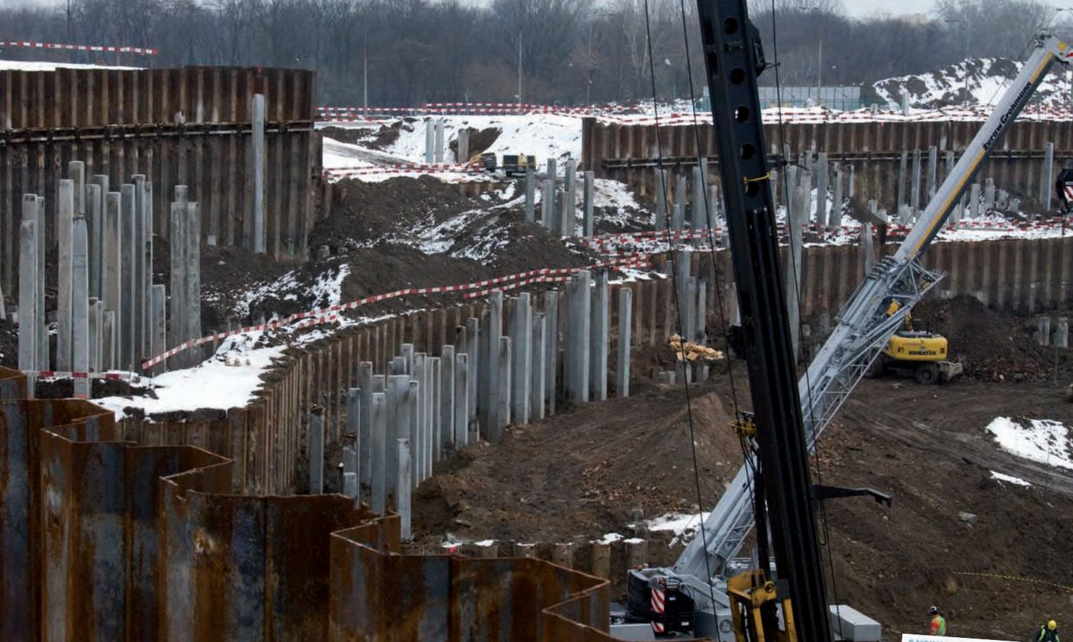
25 lutego 2009 r. - pale gotowe do przycięcia i budowania oczepów FOT. JERZY PRZYWARA
