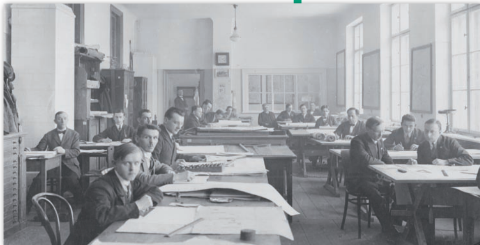
Pracownia Oddziału Pomiarów w budynku magistratu przy pl. Wolności 14 (fotografia z drugiej połowy lat 20.)
