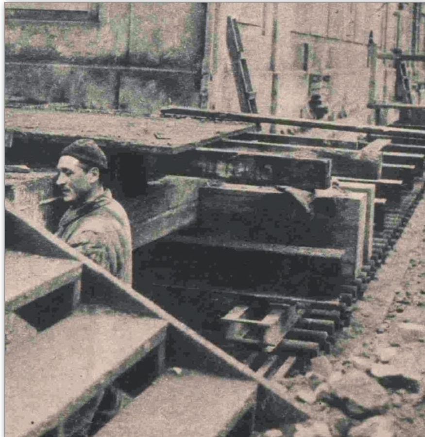
Konstrukcja do przesuwu kościoła wraz z osadzonym na niej budynkiem
