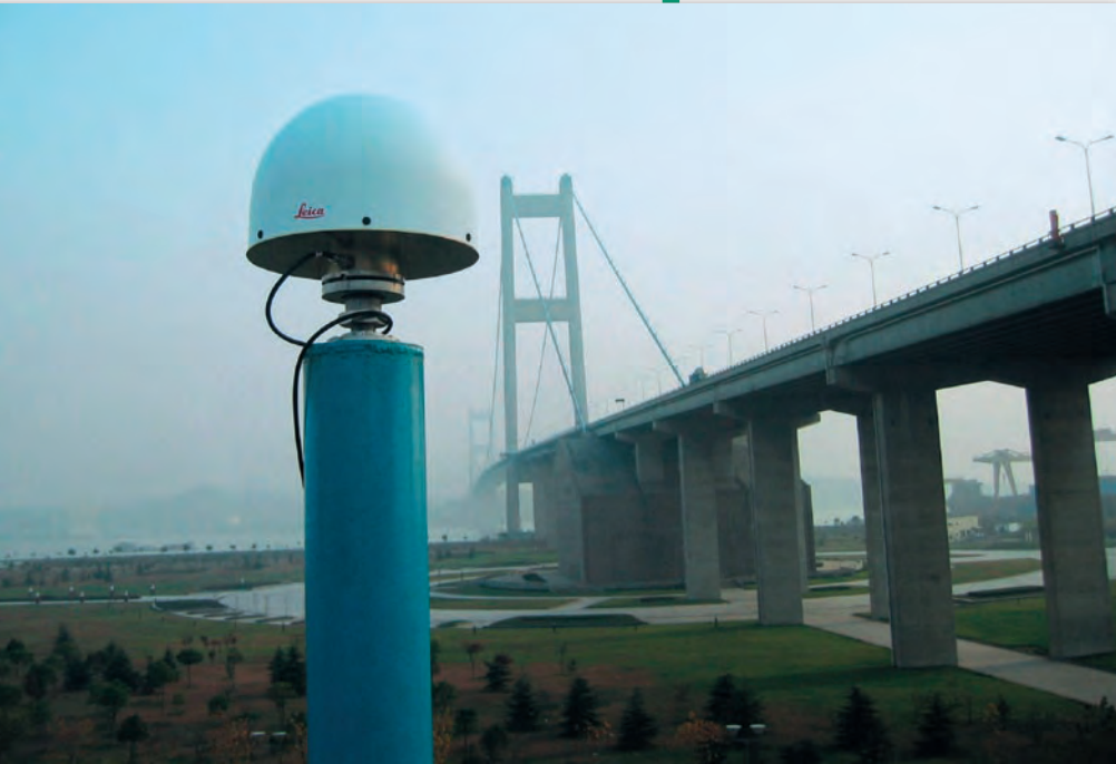
Rys. 6. Stacji bazowa GPS na tle monitorowanego mostu w Jiangyin, Chiny
