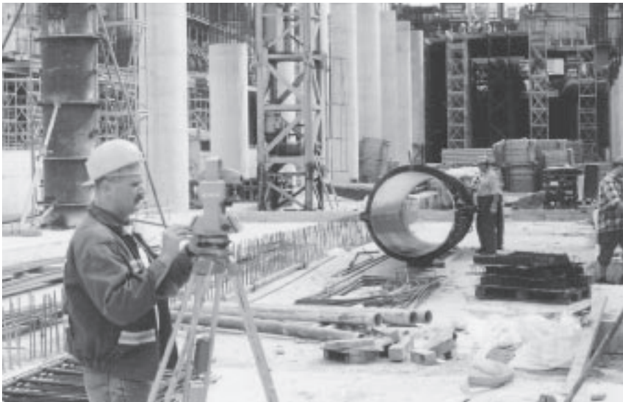
Prace w największym budowlanym wykopie Europy.
