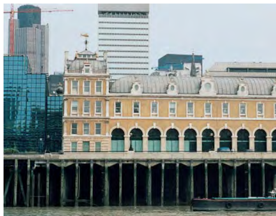
W dokach budowie ze stali, betonu i szkła kłóca się z zabytkowymi magazynami
