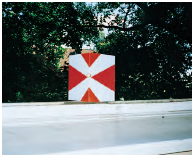
Fot. 1. Konstrukcja narożnego ściennego znaku – sygnału geodezyjnego
