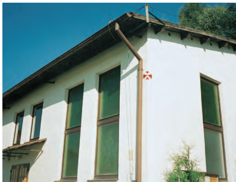
Fot. 2. Sposób utrwalenia znaku na budowlu
