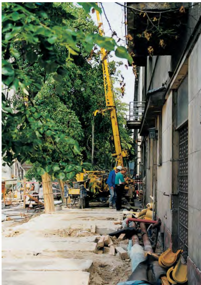
▲ Palowanie budynku Biblioteki Lekarskiej
