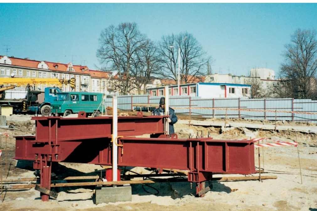
Pomiar osiadania pali
