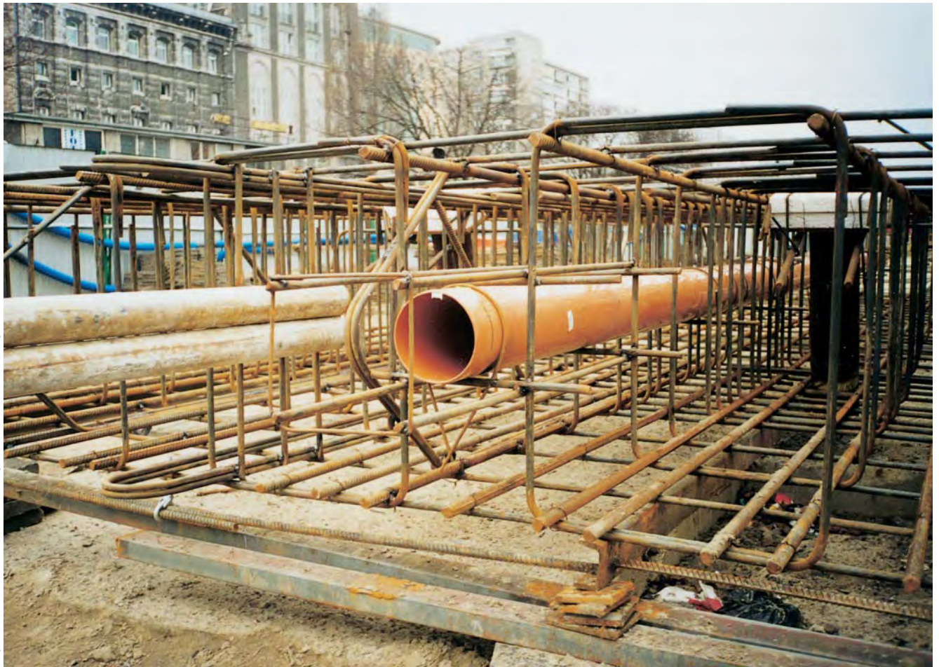
Rys. 1. Rura inklinometru przytwierdzona do zbrojenia
