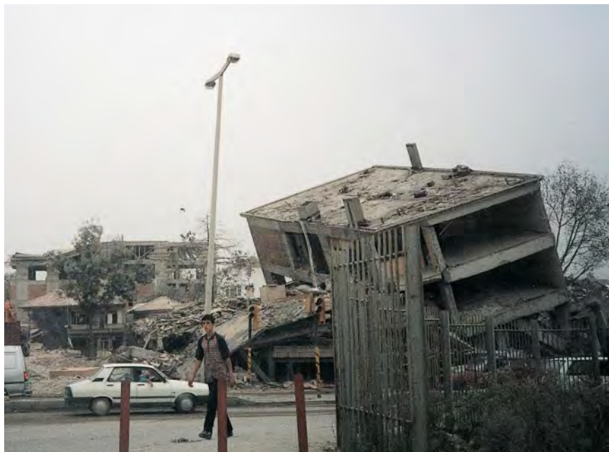
▲ Jeden z wielu budynków miasta po trzęsieniu ziemi
