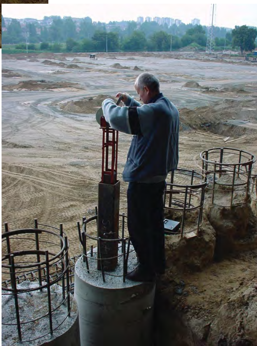
Fot. 3. Pomiary inklinometryczne dotyczące przemieszczeń, zmian nachylenia i ugięć ściany utworzonej przez pale wiercone
