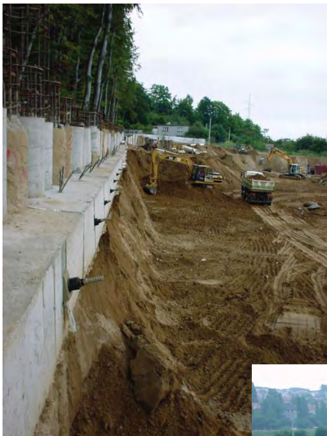
Fot. 2. Pomiary inklinometryczne ściany oporowej podtrzymującej zalasione wzgórze, którego część została usunięta w celu „wygospodarowania” terenu na budowę
