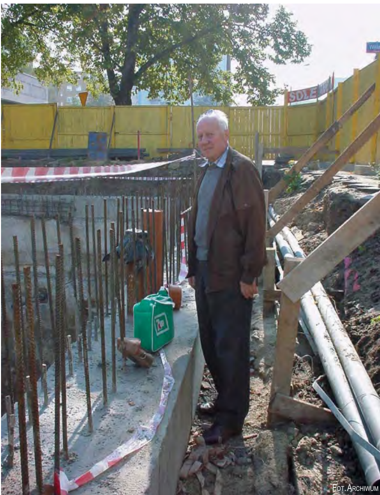
Na budowie przy stanowisku inklinometru
