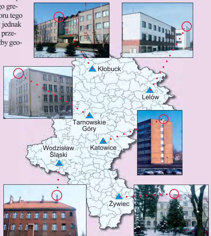
Lokalizacja anten GPS stacji referencyjnych
