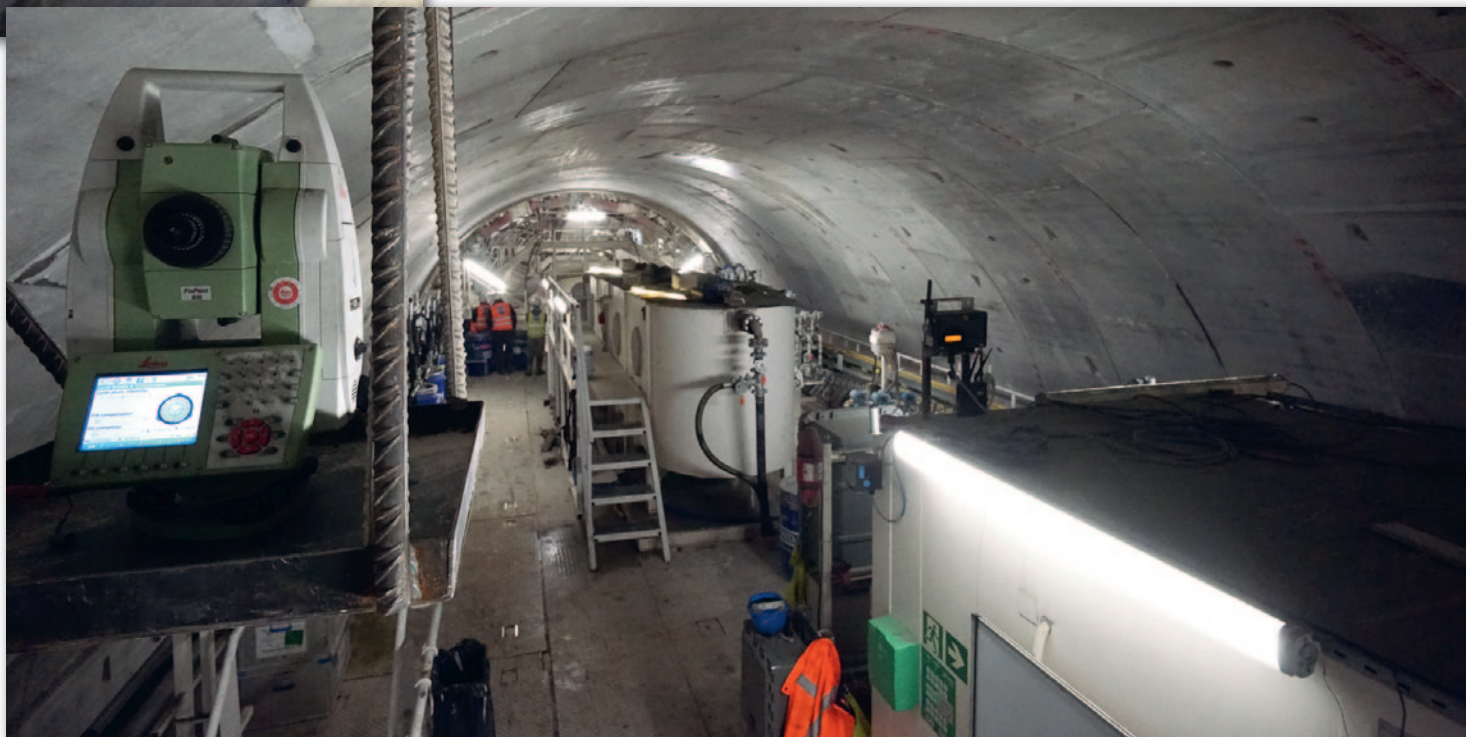
Fragment dużej tarczy TBM „Katarzyna” i tachimetr dostarczający danych systemowi nawigacyjnemu VMT
