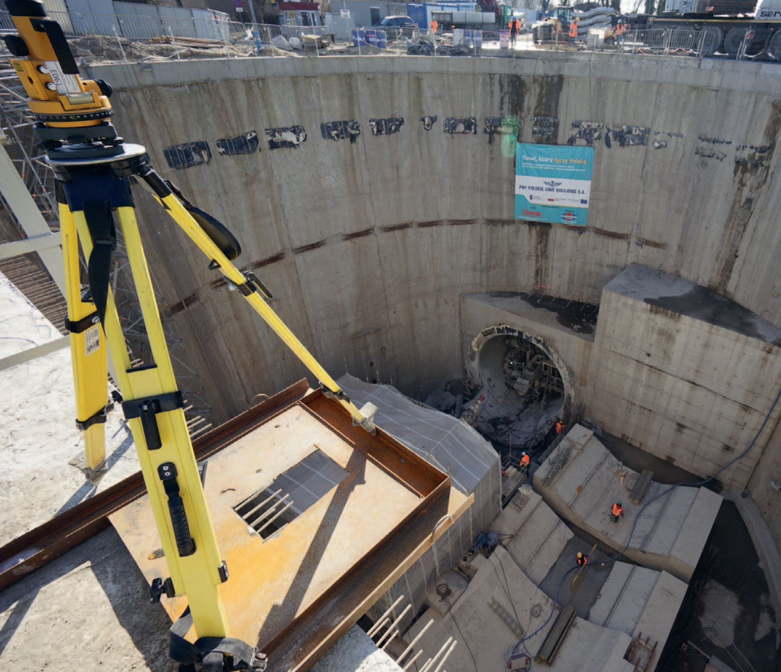
Widok ściany okularowej w jednym z szybów rozgałęźnych
