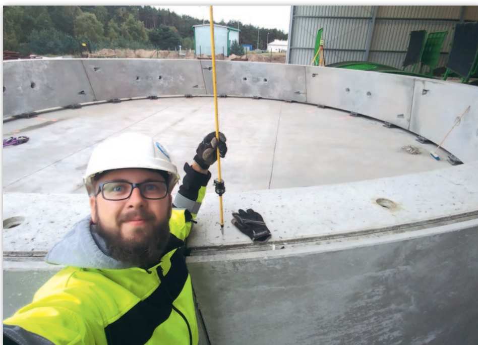
Kontrola próbnego montażu pierścienia obudowy tunelu
