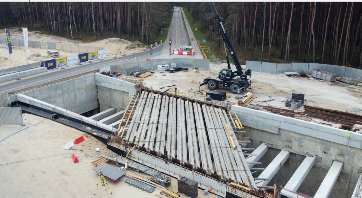
Geodezyjna obsługa budowy wiaduktu nad częścią rampową tunelu na wyspie Uznam
