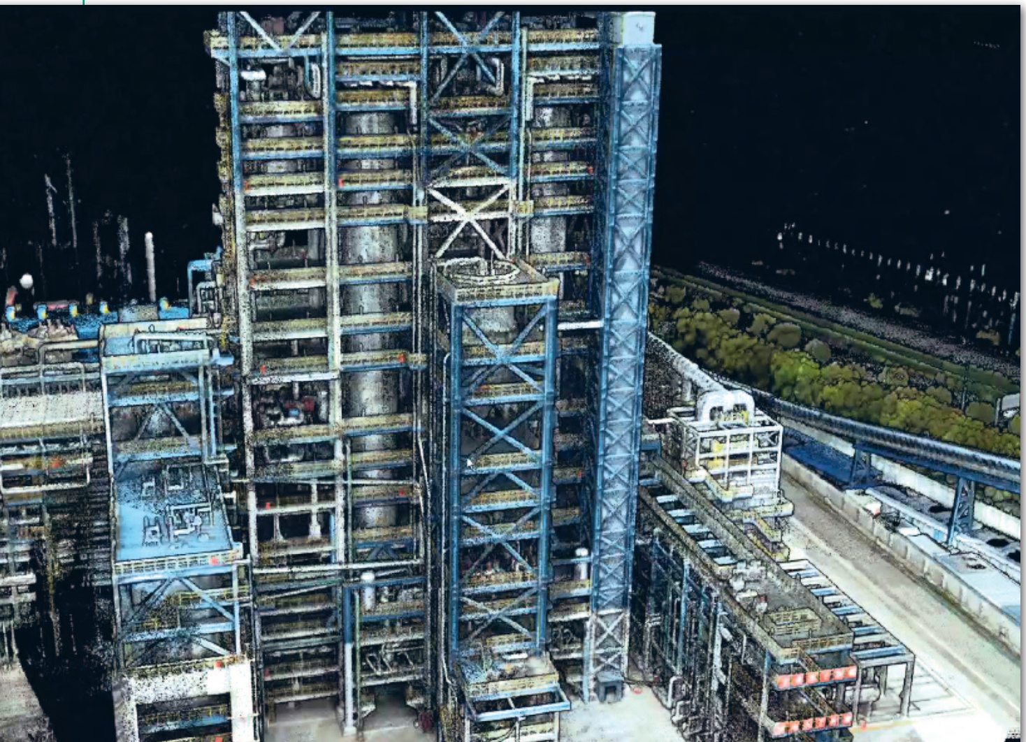
Wynik skanowania obiektów pionowych na placu budowy
