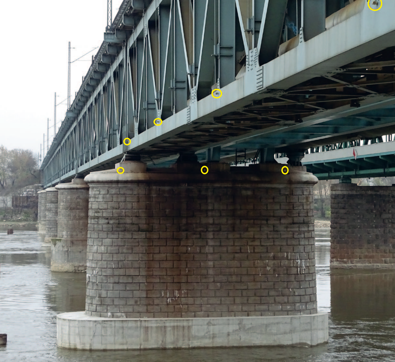
Punkty pomiarowe na Kolejowym Moście Gdańskim w Warszawie
