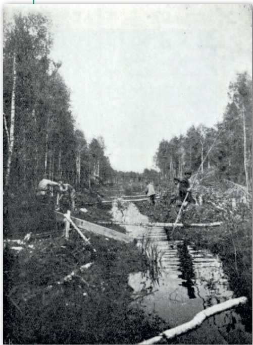
Wykonywanie przesieki podczas prac pomiarowych na granicy
