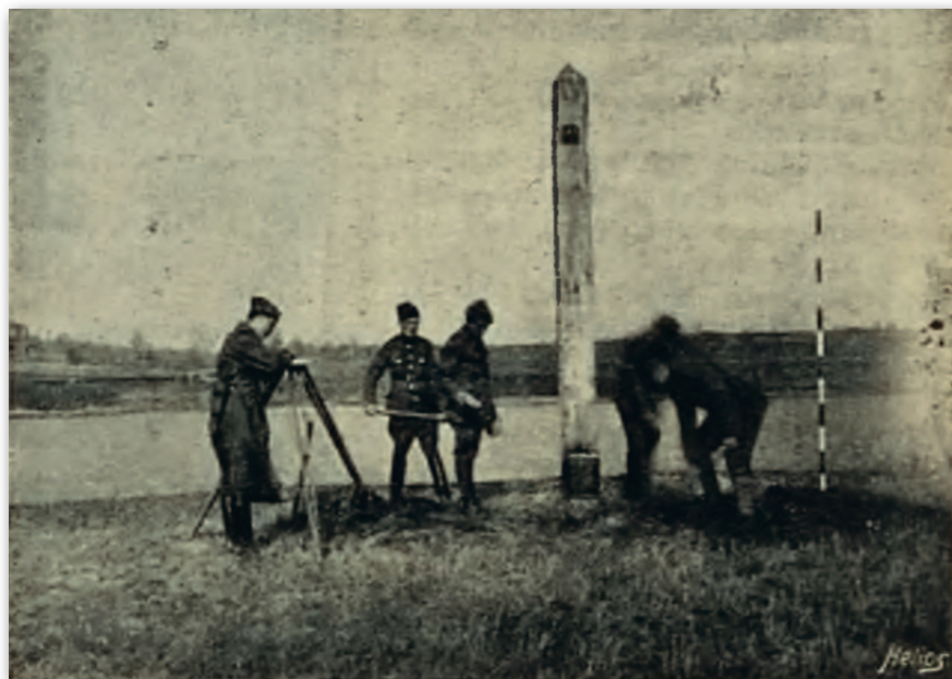
Wykonywanie szkiców pomiarowych słupa granicznego
