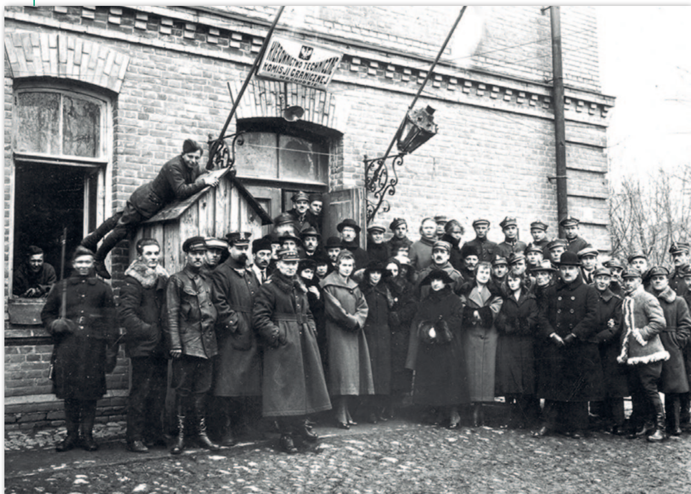
Komisja techniczna (pomiarowa) Mieszanej Komisji Granicznej (w płaszczu z kołnierzem futrzanym przewodniczący płk Piotr Rybarski)
