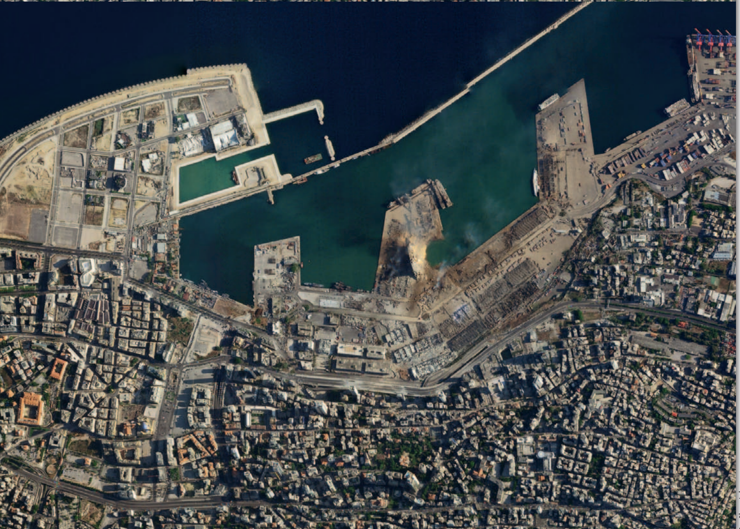
Skala zniszczeń po eksplozji w stolicy Libanu, Bejrut 31 maja i 5 sierpnia 2020 roku
