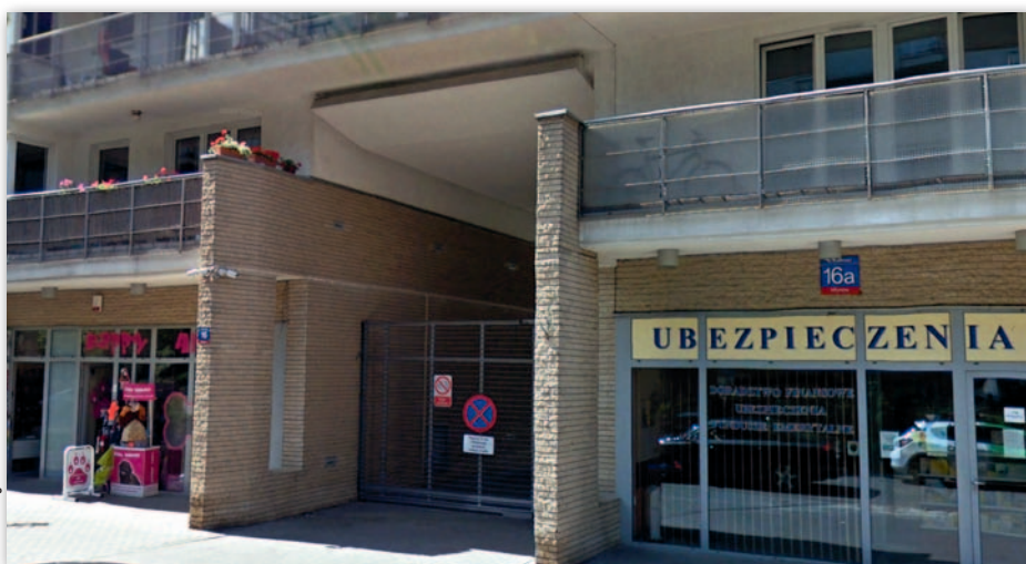
Z kolei numerami 16 i 16A oznaczone są dwa graniczące ze sobą i połączone ścianą budynki z bramą wjazdową na poziomie pierwszej kondygnacji (widok od strony ulicy Radziwie)
