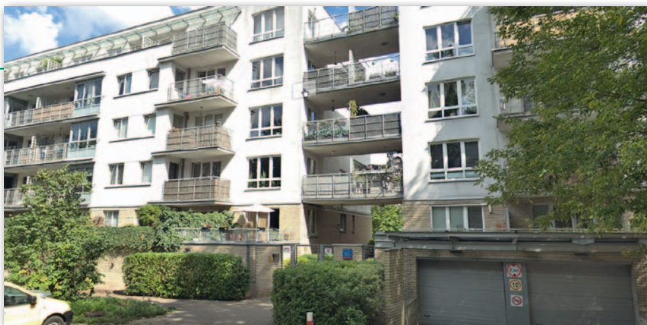
Części budynku oznaczonego numerem 16 w kilku miejscach połączone są tylko balkonami (widok od strony ulicy Zawiszy). Natomiast błędne przedstawienie na mapie ewidencyjnej sugeruje, że mamy do czynienia z dwoma osobnymi budynkami
