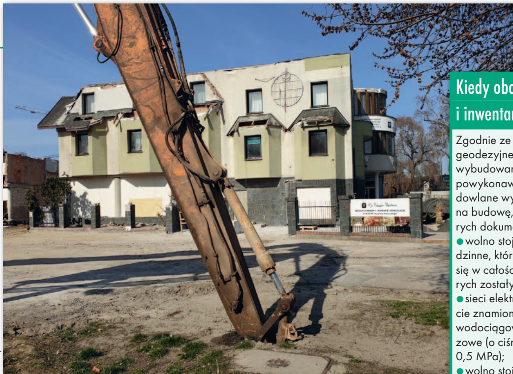
Hotel Czarny Kot – najśtywniejsza samowola budowlana w Warszawie (w trakcie rozbiórki)
