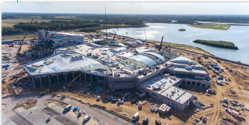
Budowa „Suntago Wodny Świat”, sierpień 2019 r.
