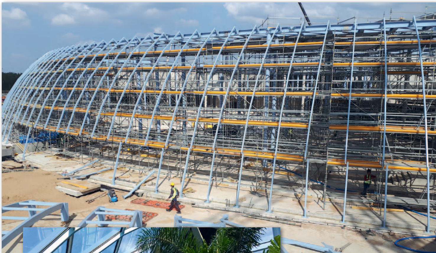
Konstrukcja stalowa elewacji szklanej
