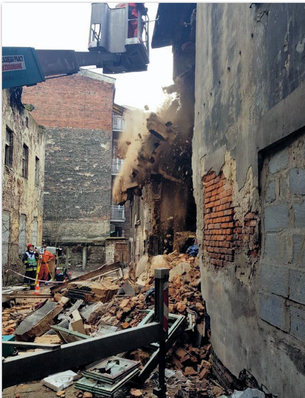
Wyburzenie kontrolowane części niezamieszkanego budynku podczas akcji w Bytomiu, marzec 2018 r.
