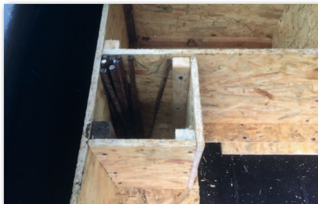
Fot. 10. Zabudowa na rurki i pręty
