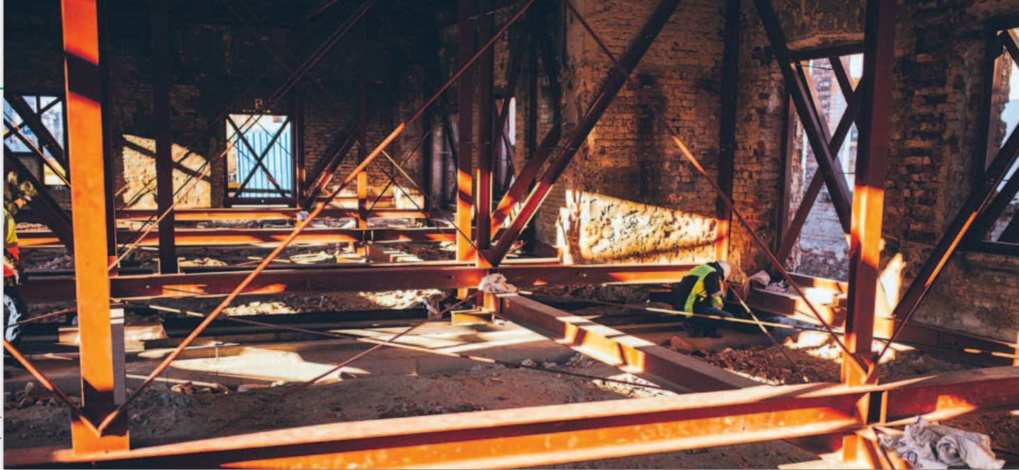
Wnętrze budynku wzmocnione do relokacji stalowymi słupami
